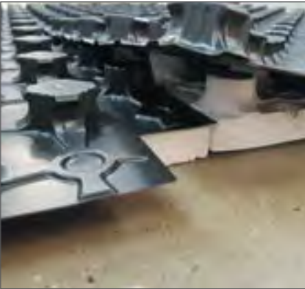
Рис. 2.6.1. «Замковое» соединение плит «Экопол 20»
