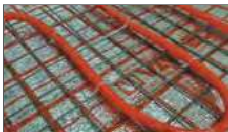
Рис. 2.7.2. Крепление труб стяжными хомутиками к сетке
