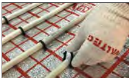
Рис. 2.7.4. Установка гарпунных скоб вручную
