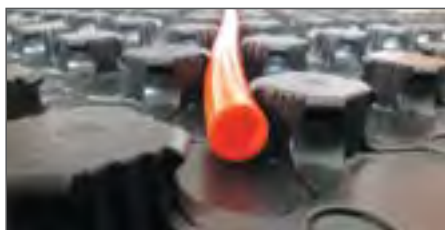
Рис. 2.7.1. Крепление труб между «бобышек» теплоизоляционных плит
