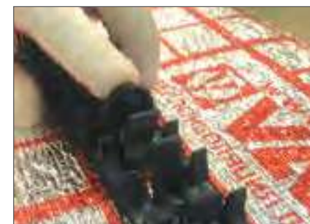
Рис. 2.7.7. Крепление шины гарпунной скобой к теплоизоляции
