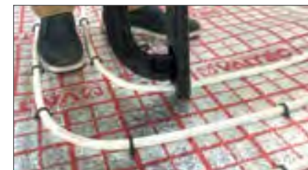
Рис. 2.7.5. Крепление труб скобами с помощью такера VT.T.01
