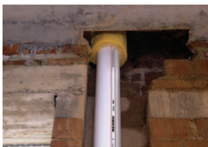
Рис. 3-9 Проход в перекрытии
