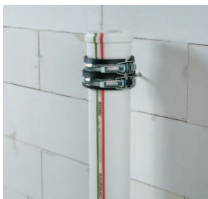
Рис. 4-4 Установленный шумопоглощающий хомут
