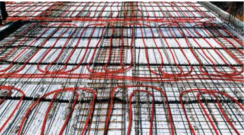
5 Рис. 6: Модули BKT REHAU, уложенные на месте перед бетонировкой перекрытия
