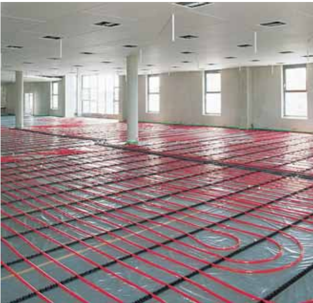
1 Рис. 3: Фиксирующие шины REHAU RAUFIX
