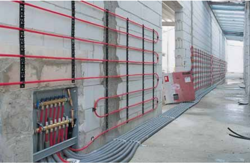
3 Рис. 10: Монтаж системы настенного отопления "мокрым" способом
