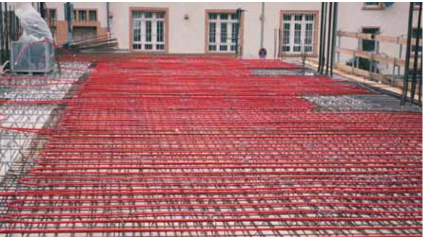
5 Рис. 4: Модуль BKT REHAU, закладываемый в перекрытие
