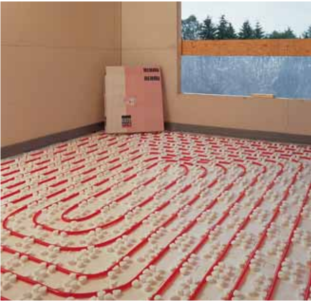
1 Рис. 1: Система крепления труб на маты с фиксаторами vario
