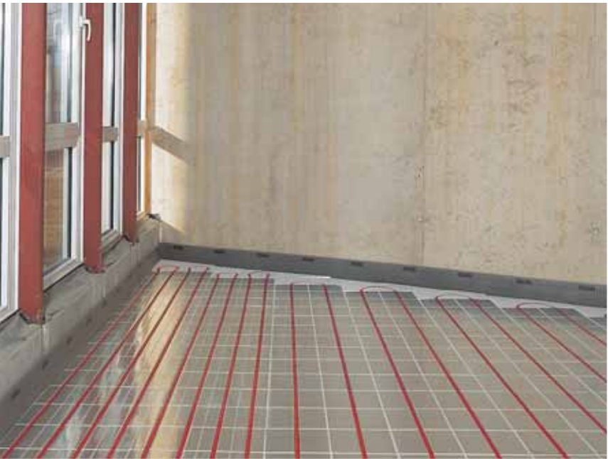
1 Рис. 34: Сухая система укладки REHAU
