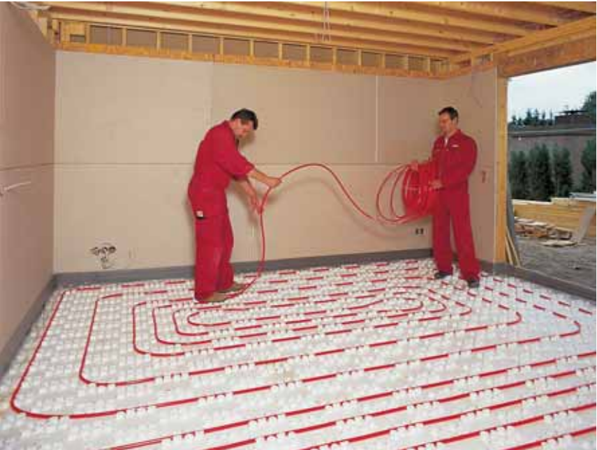
1 Рис. 9: Монтаж на матах с фиксаторами vario
