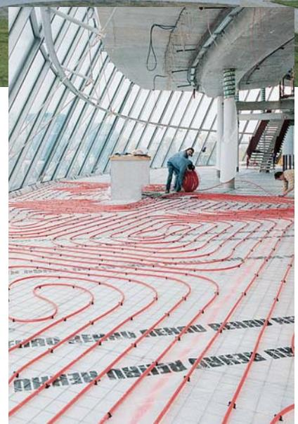
ных, так и на поперечных перемычках сетки. Поворотные клипсы монтируют стоя, при помощи штока для крепления клипс, что обеспечивает оптимальную для работающего высоту.
