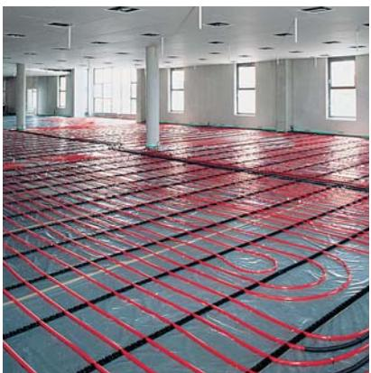
Шины укладываются на изоляцию. Пленочное покрытие делает систему применимой с жидкой стяжкой. Крючки на нижней стороне шин предотвращают смещение шин до момента их окончательного крепления скобами. Крепежные скобы вдавливаются рукой в изоляцию, таким образом обеспечивается быстрый и несложный монтаж.
