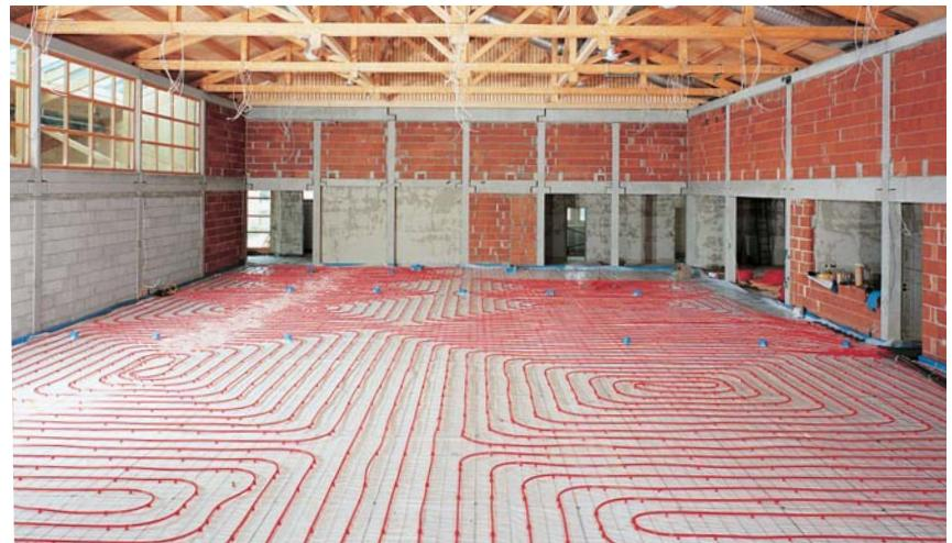
Напольное отопление при этом монтируется в нижней части конструкции вибропола, благодаря чему достигается приятное темпериравание поверхности спортивной площадки. Высокая составляющая лучистого тепла обеспечивает благоприятный климат. Предотвращается опасность травмирования об отопительные приборы. Благодаря обогреву большой поверхностью устанавливается
