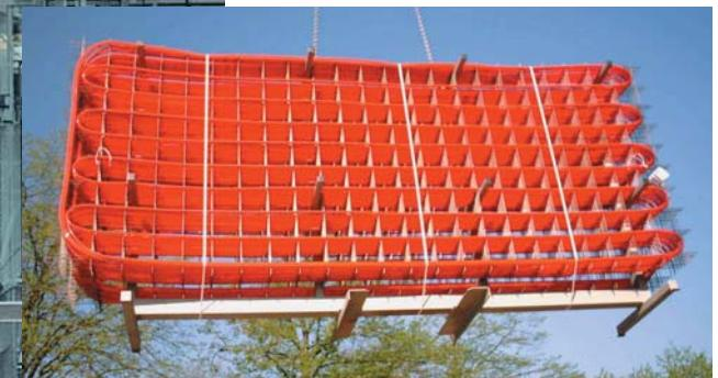
Именно поэтому метод темперирования здания является наиболее благоприятным для окружающей среды и одновременно комфортным. Система для темперирования перекрытий может быть смонтирована на месте или при помощи предварительно подготовленных модулей. Помимо трубы RAUTHERM S и соединения на надвижной гильзе находят применение и другие испытанные компоненты.
