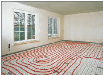
Рис. 15.5-1 Система крепления труб с помощью гарпун-скоб
