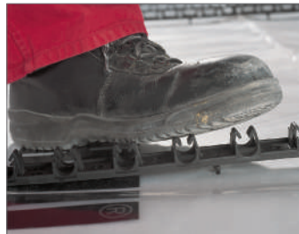
Рис. 15.5-11 Вдавливание фиксирующих шин RAUFIX в конструкцию пола
