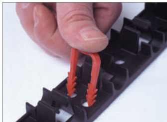
Рис. 15.5-12 Вдавливание гарпун-скоб в конструкцию пола
