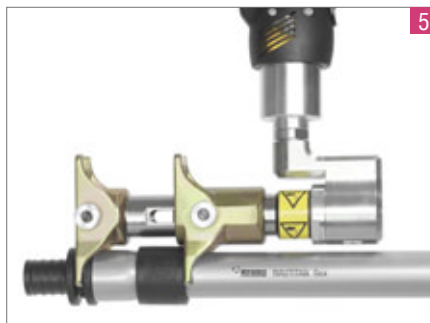
Установить запрессовочные тиски
