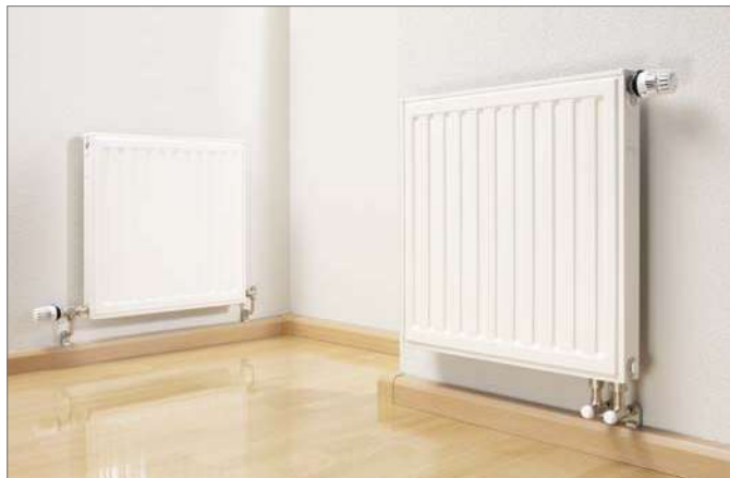
Рис. 18.1. Подключение отопительного прибора из плинтусного канала
