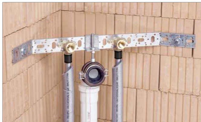
Рис. 6-3. Пример установки монтажной шины
