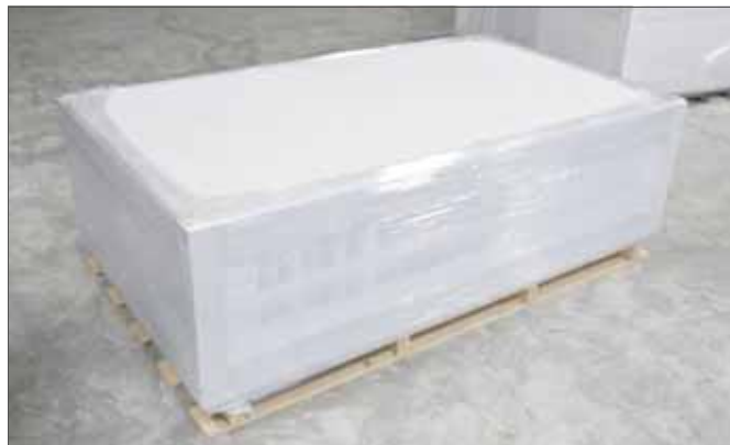
Рис. 4-11 Доставка и хранение потолочных панелей
