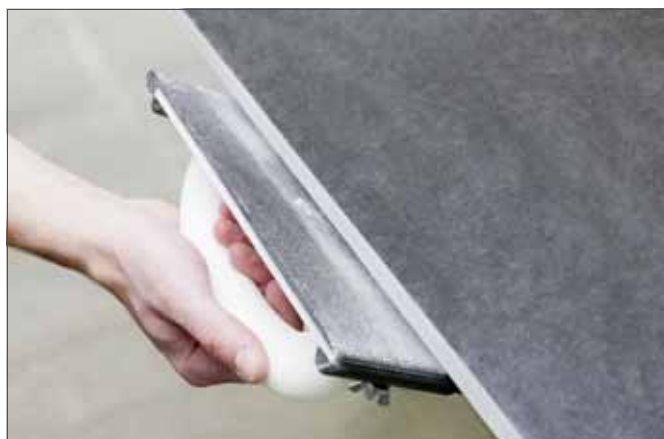
Рис. 4-17 Шлифование торца
