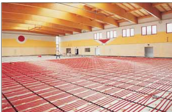
Рис. 14-1 SBH Система со стандартным распределительным коллектором
