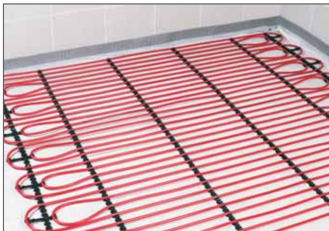
Рис. 3-62 Напольная фиксирующая шина для мокрого способа монтажа
