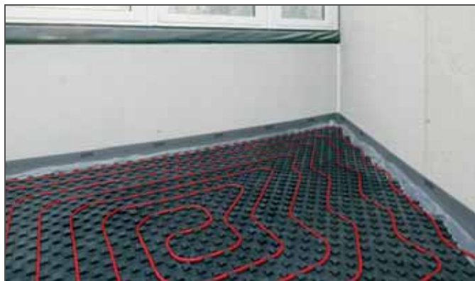
Рис. 3-11 Маты с фиксаторами Varionova с шаго-звукоизоляцией 30-2 снизу
