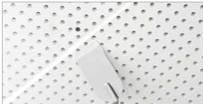
Рис. 4-26 Шпаклевание головок шурупов
