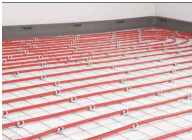
Система крепления труб на арматурной сетке
