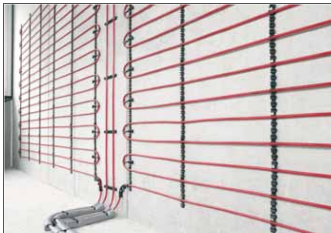
Рис. 7-1 Настенные обогрев и охлаждение при «мокроем» способе монтажа
