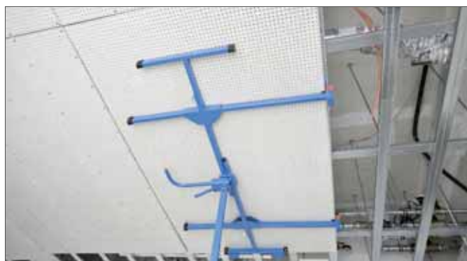
Рис. 4-21 Подъемник плит для правильного расположения элементов потолка
