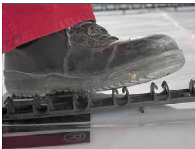
Рис. 3-34 Вдавливание фиксирующих шин RAUFIX в конструкцию пола
