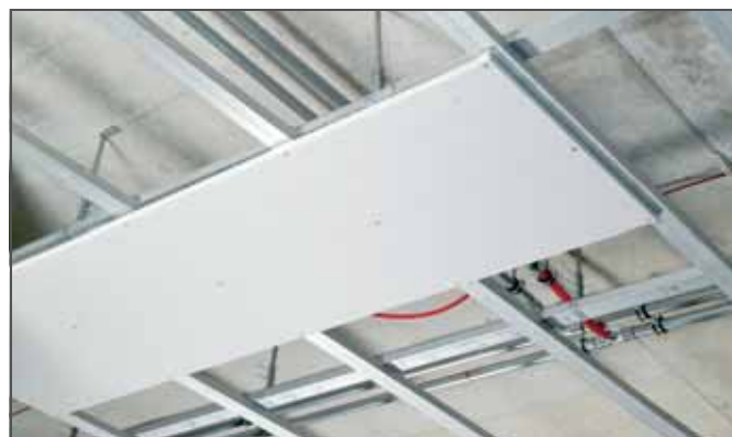
Рис. 7-20 Стеновая панель обогрева и охлаждения, смонтированная на потолке
