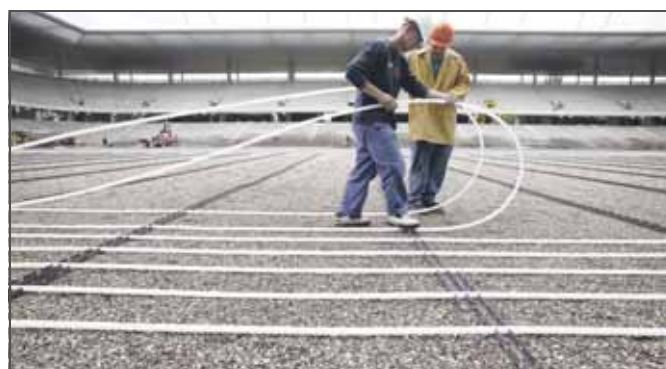
Рис. 16-3 Укладка отопительных труб
