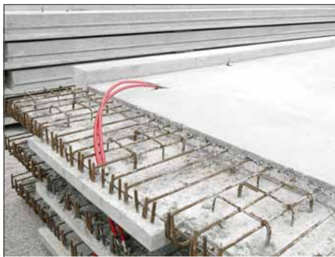
Рис. 11-4 REHAU ВКТ из полуготовых частей
