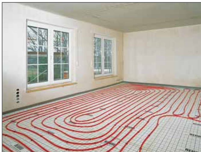
Рис. 3-22 Система крепления труб с помощью гарпун-скоб
