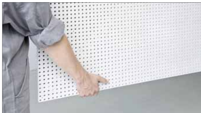
Рис. 4-12 Ручная переноска панели на стройплощадке
