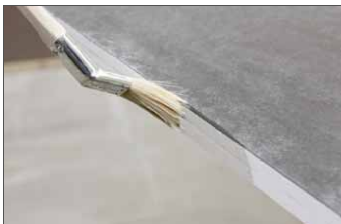
Рис. 4-18 Загрунтованные края
