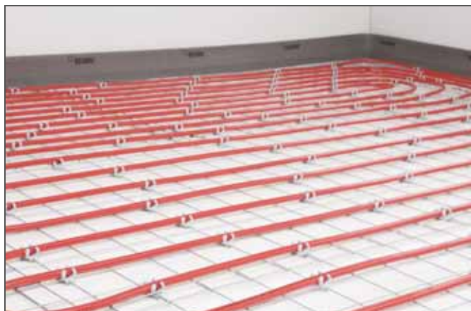
Рис. 3-38 Система крепления труб на арматурной сетке
