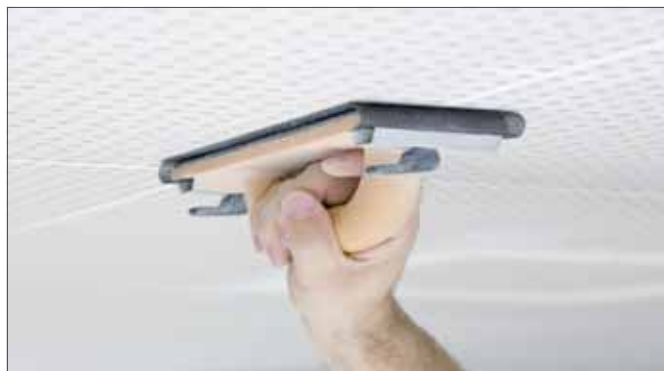
Рис. 4-27 Шлифование поверхности
