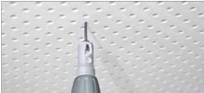
Рис. 4-22 Монтаж гипсокартона шуруповертом с ограничителем глубины
