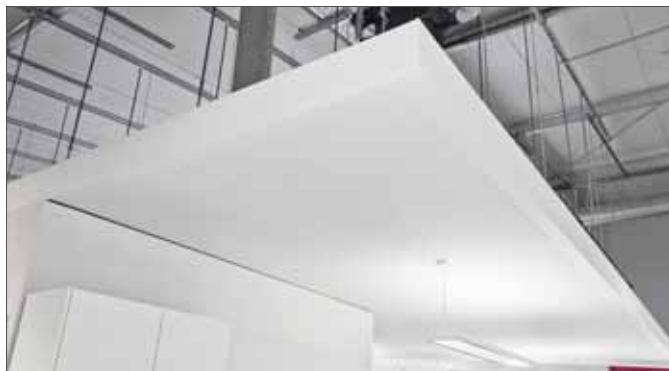
Рис. 4-8 Пример изготовления потолка-паруса
