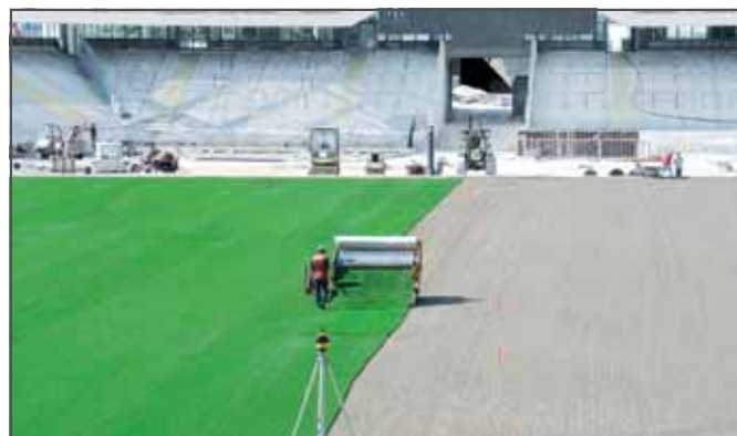
Рис. 16-4 Укладка газона
