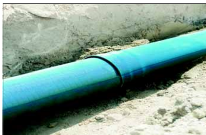
Рис. 16-2 Укладка дренажа на игровом поле
