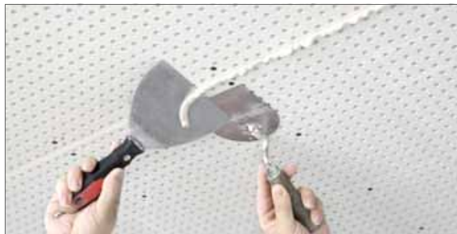
Рис. 4-25 Снятие шпаклевки
