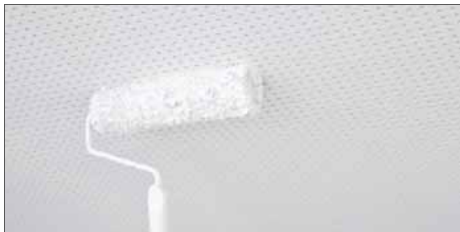
Рис. 4-28 Нанесение краски валиком
