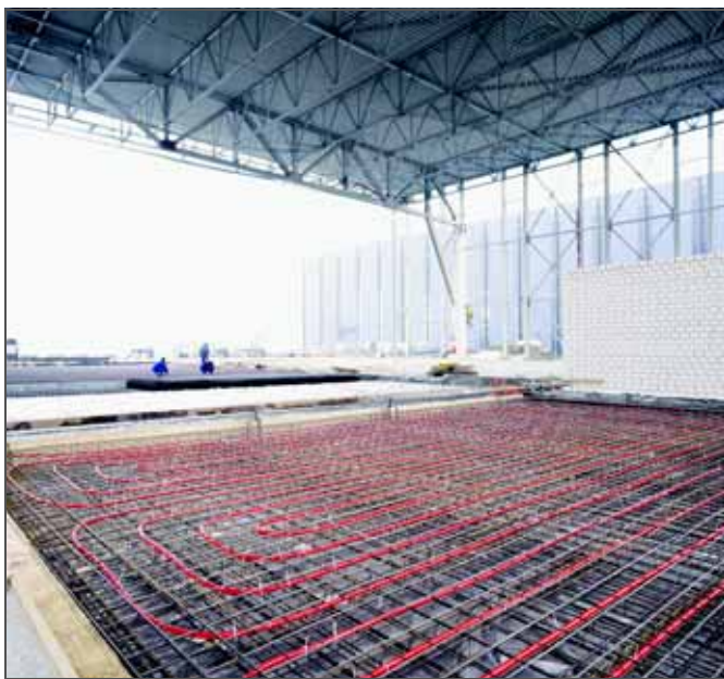
Рис. 12-1 Напольное отопление в промышленном цехе
