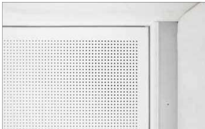
Рис. 4-31 Пример скользящего примыкания к стене
