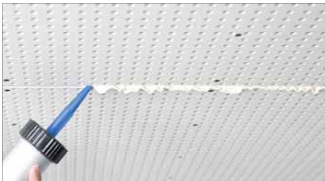
Рис. 4-24 Заполнение зазора по всей толщине панели 20 мм
