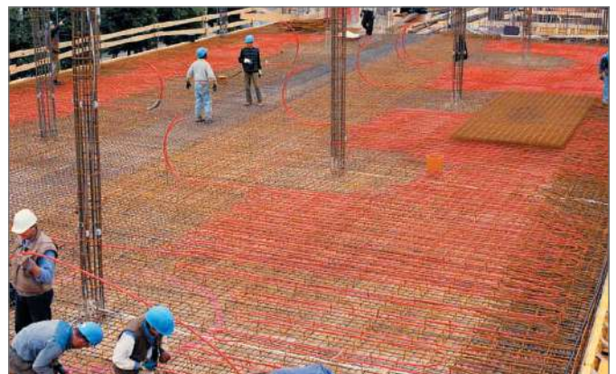
Рис. 8-5 Модули ВКТ RENAU, укладываемые на месте
