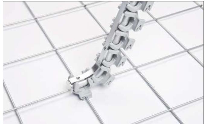
Рис. 3-49 Установить штангу с магазином поворотных клипс
