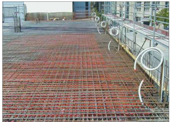
Рис. 8-2 Участок бетонирования ВКТ
