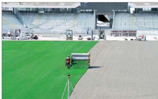
Рис. 9-35 Укладка газона
