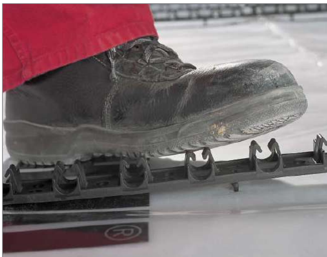
Рис. 3-34 Вдавливание фиксирующих шин RAUFIX в конструкцию пола
