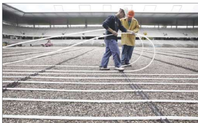
Рис. 9-34 Укладка отопительных труб
