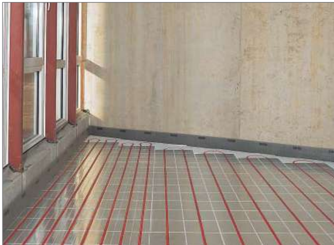
Рис. 3-49 «Сухая» система укладки труб
