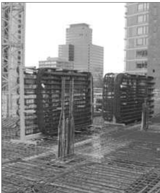
Подогрев и охлаждение ядра бетонных перекрытий
