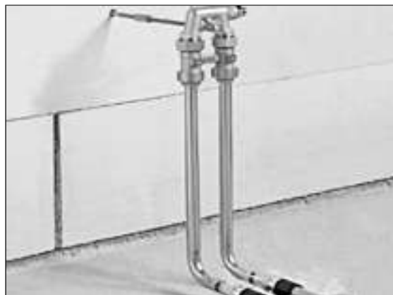
Готовый монтажный блок для подключения отопительного прибора.
