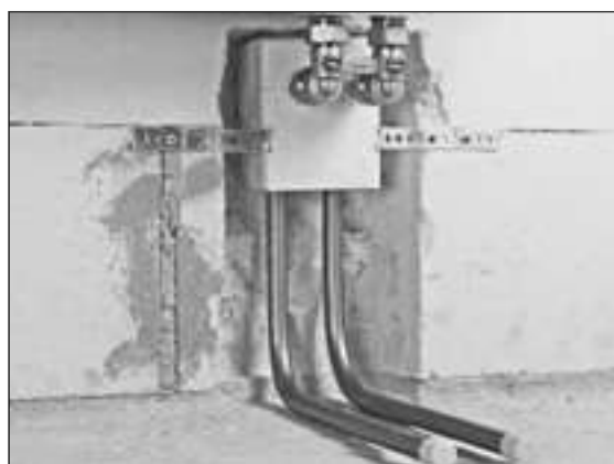
Присоединительный блок RAUTITAN для подключения отопительного прибора.
