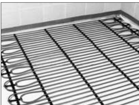
Система напольного отопления/охлаждения («мокрый» способ укладки труб)
