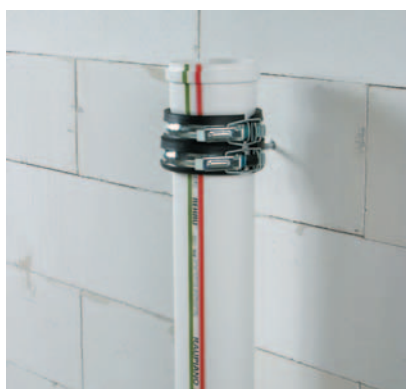
Рис. 4-4 Установленный шумопоглощающий хомут
