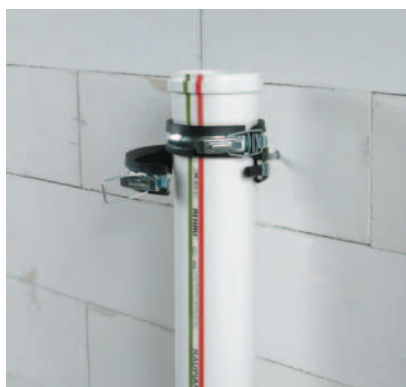
Рис. 4-3 Монтаж опорного хомута
