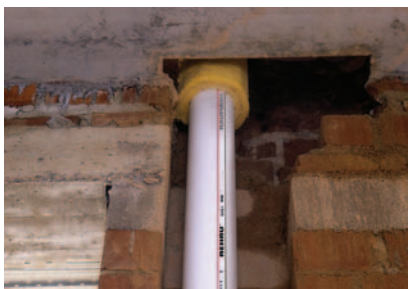
Рис. 3-9 Проход в перекрытии
